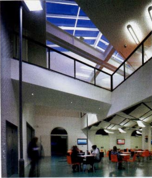
Das Dach wurde geöffnet und bringt Tageslicht in ehemals dunkle Bereiche
